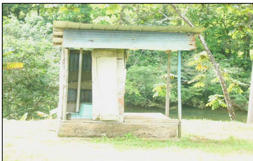
Infraestructura sanitaria en el tramo medio de la subcuenca del río Boquerón
