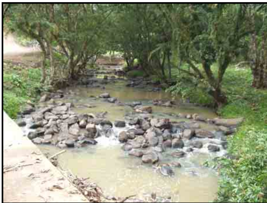
Figura No. 4.2.4.1.4-1 El Río Tinajones aguas abajo de la Toma del Filtro Lento
