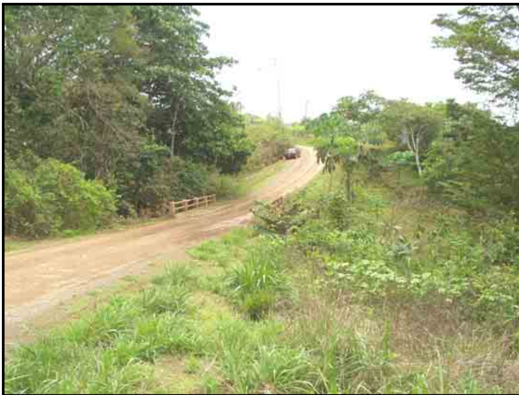
Figura No. 2.2.2.1.1-1 Ubicación del Aforo, Puente del Río Caño Quebrado
