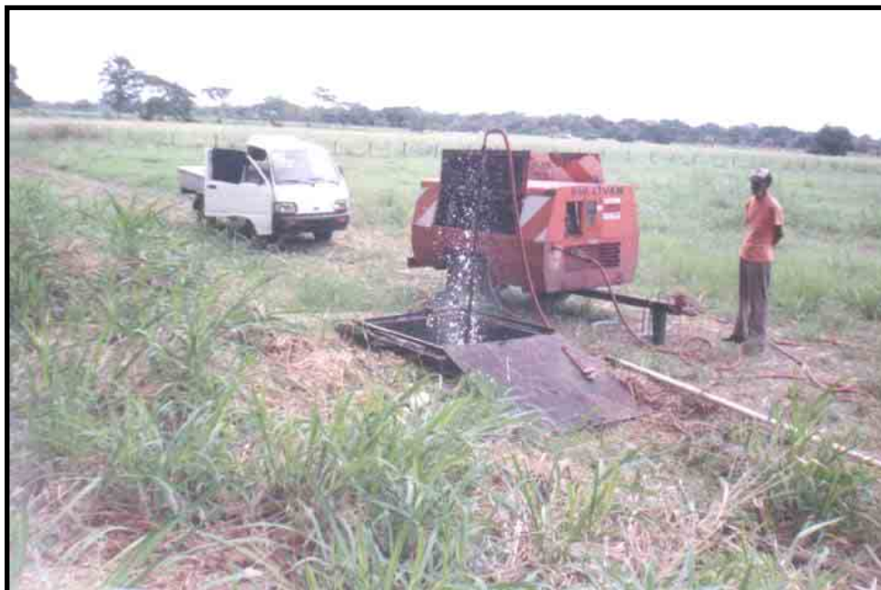
Figura No. 4.1.4-2 Ejemplo de limpieza del sistema de pozos punteras en el área de Río Chame, realizada por la empresa HidroGeo Servicios Consultores, S.A., (2,000)
