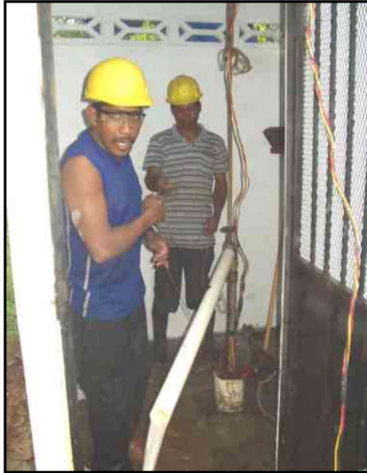
Figura No. 2.2.1.3.4.1-1 Prueba de bombeo en el Pozo S/N, Divisa.
