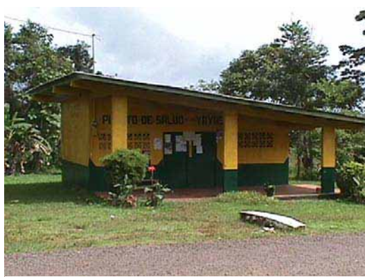
Puesto de salud en la comunidad de Las Zanguengas. Actualmente no está en funcionamiento
